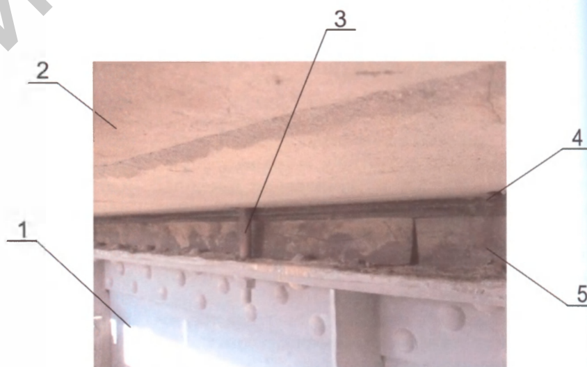
1 - продольная балка; 2 - плита БМП; 3 - высокопрочная шпилька; 4 - резиновая прокладка; 5 - деревянная прокладка
