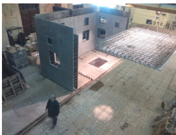
Рис. 1. Общий вид несъемной сталефибробетонной опалубки
