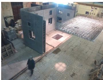
Рис. 1. Общий вид несъемной сталефибробетонной опалубки
