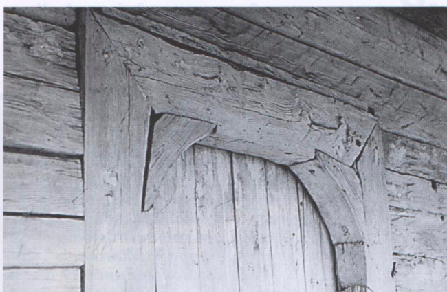
Рисунок 18 — Завершение дверного проема в костеле в Каменполье Миорского р-на, первая половина XX в.
