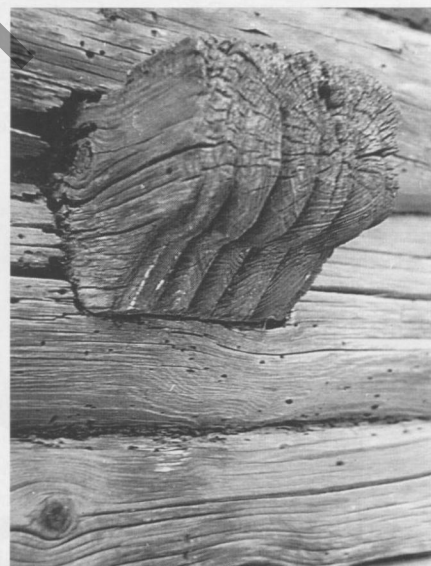
Рисунок 13 — Торец главной балки жилого дома в Бабичах Речицкого р-на
