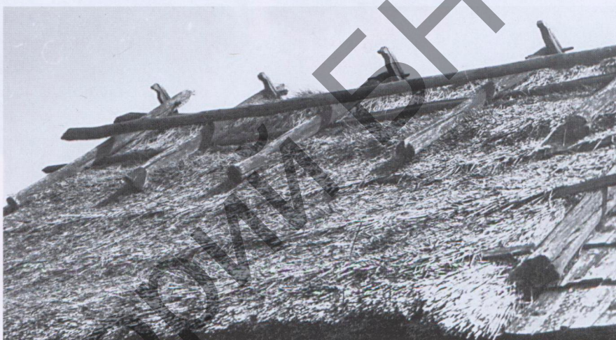
Рисунок 21 — Крепление конька соломенного покрытия хлева в Катке Глусского р-на
