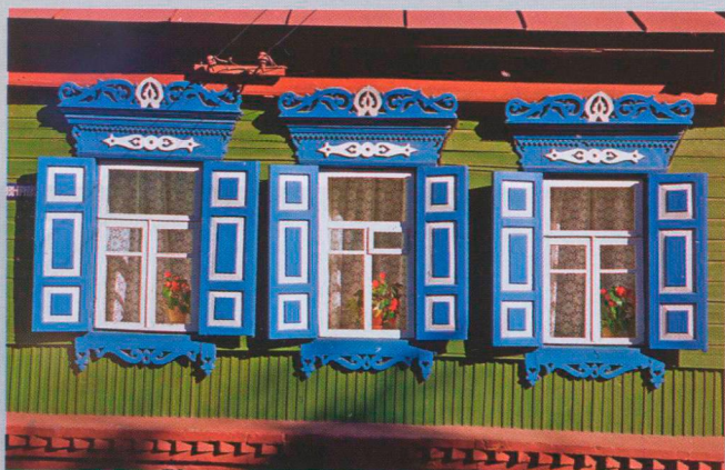
Рисунок 17 — Окна жилого дома в Гомеле
