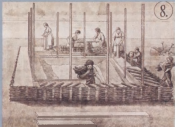
Рисунок 8 — Устройство цоколя
