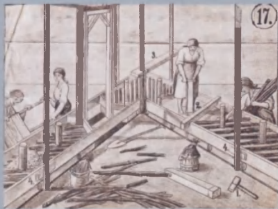
Рисунок 12 — Технология и приспособления для возведение стен из глины
