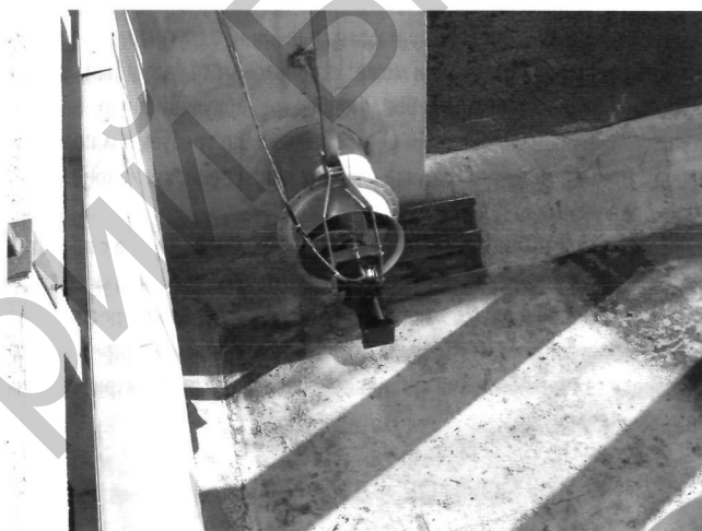
Рис. 9. Рециркуляционный насос WILOEMU RZP
