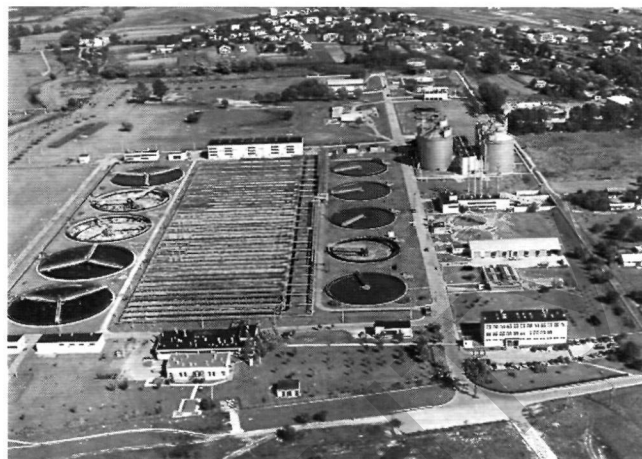
Рис. 7. Вид очистных сооружений г. Люблина с высоты птичьего полета
