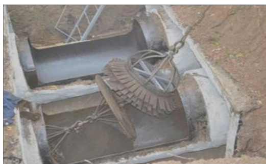
Рисунок 1 – Прочистка трубы механическим способом
