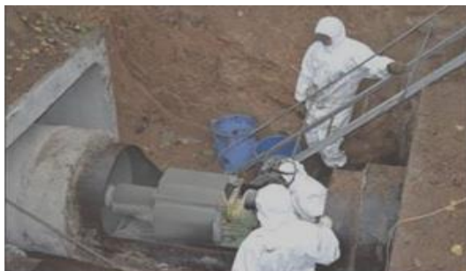
Рисунок 2 – Нанесение цементно-песчаного покрытия электрической металательной головкой
