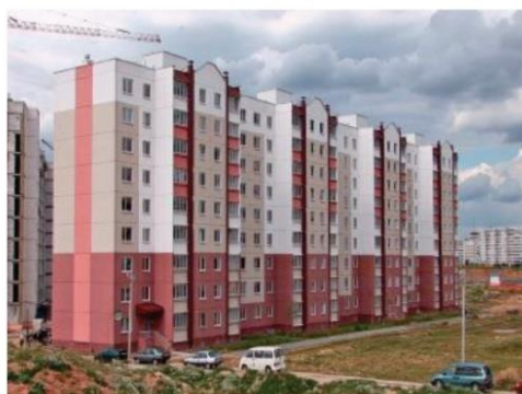
Рисунок 2. Энергоэффективный дом по ул. Притыцкого
