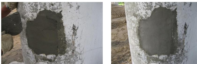
Рис. 2.2.20. Восстановление защитного слоя промежуточной опоры
