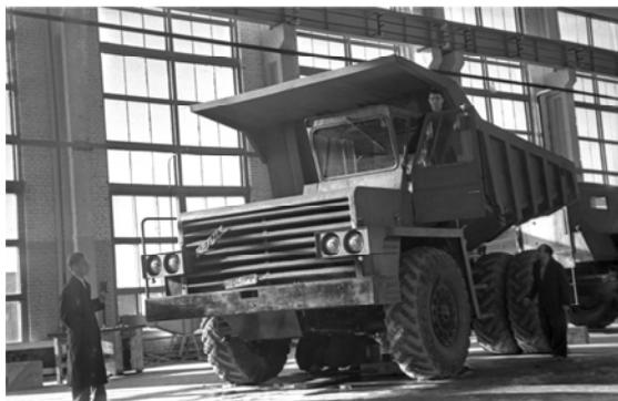
Рис. 1. Карьерный самосвал БЕЛАЗ-540 грузоподъемностью 27 тонн.
