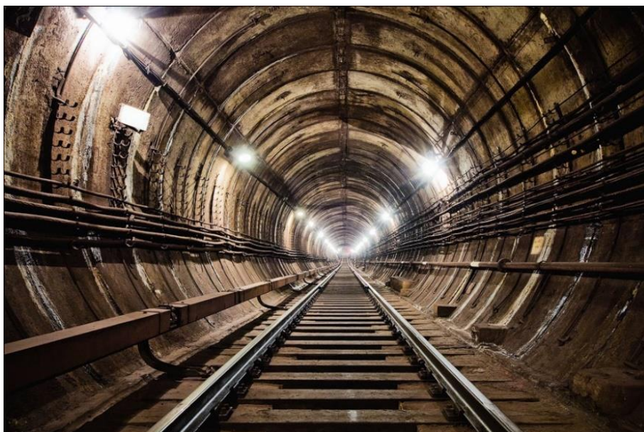
Рисунок 1 – Вид тоннеля изнутри
