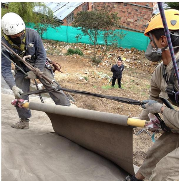
Рисунок 2 – Укладка бетонного полотна
