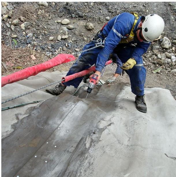
Рисунок 3 – Фиксация полотен между собой
