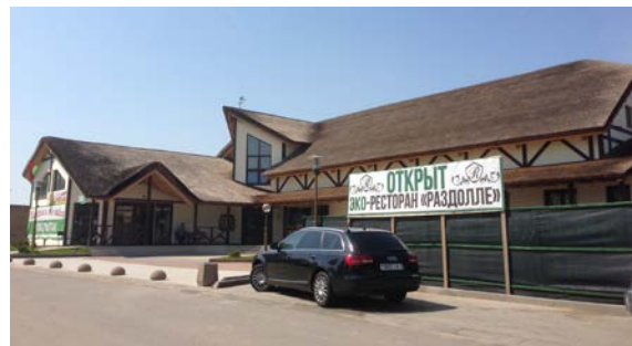
Рис. 3. Один из объектов придорожного сервиса и попутного обслуживания на автомагистрали Минск – Слуцк в пригородной зоне Минска
