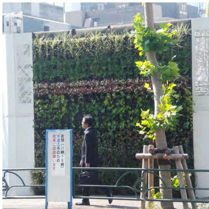
Рис. 4.10. «Живой» забор, ограждающий строительную площадку, Токио
