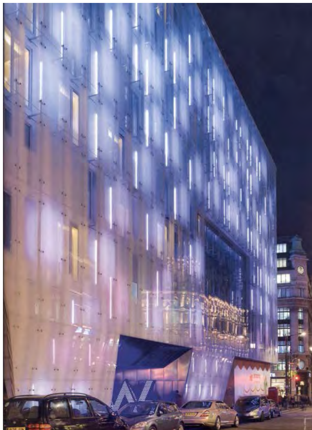
Рис. 4.8. На фасады отеля W London (архит. Дж. Вайлс и Д. Диллей) нанесен специальный отражающий слой, на который проецируются цветные изображения видов Лондона с 8 камер, установленных на крыше
