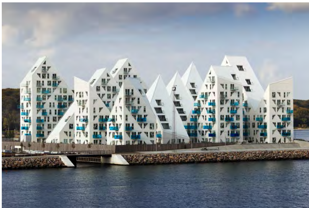
Рис. 2.2. Гармоничность архитектурно-пространственной композиции проявляется в соразмерности и соподчиненности входящих в ее состав элементов, уравновешенности масс архитектурных объемов. Жилой комплекс Айсберг (архит. бюро louis paillard, SEBRA, JDS architects, seARCH), Орхусе, Дания
