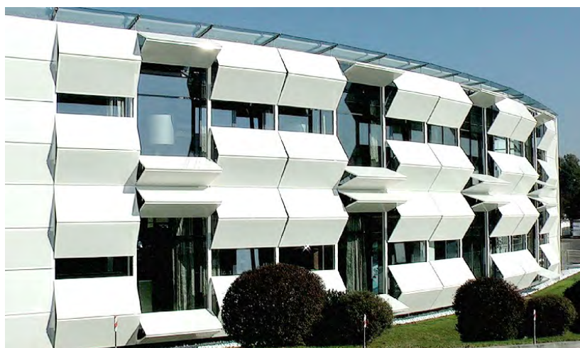
Рис. 4.9. Трансформируемый фасад здания (проектное бюро Э. Гизельбрехт и партнеры), Бад Глехенберг, Австрия
