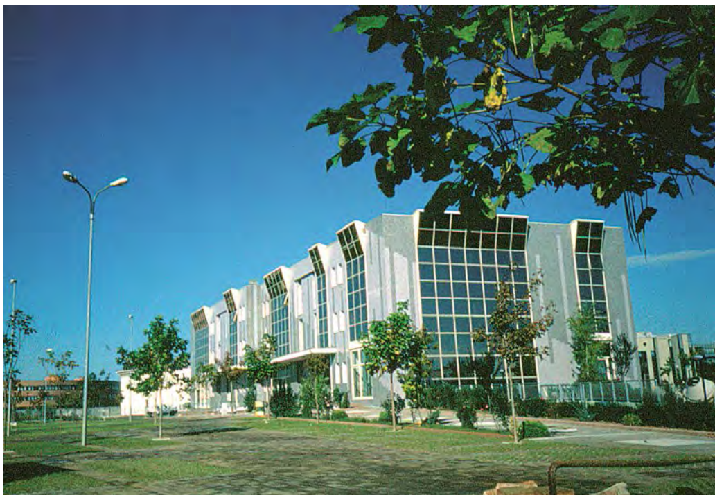
Рис. 3.19. Архитектурный облик современной производственной застройки, Римини, Италия
