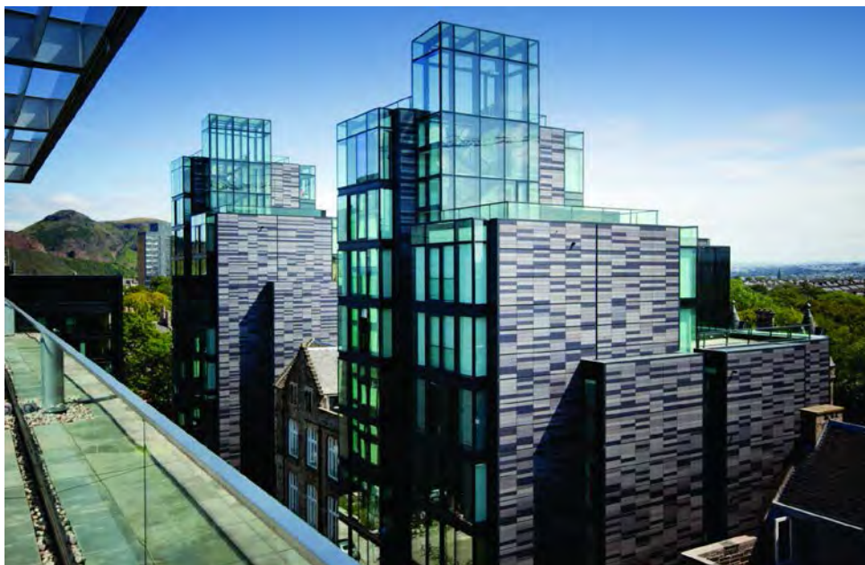
Рис. 4.16. Подбор цветовых сочетаний и размеров элементов фасадов зданий, создающих эффект «водной ряби» – здания в жилом комплексе Quatermile (архит. Н. Фостер и партнеры), Эдинбург, Шотландия
