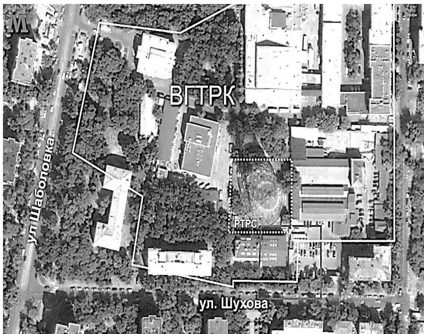
Рис. 4. Башня стоит на площадке, практически повторяющей ее периметр, принадлежащей ее балансодержателю ФГУП РТРС, эта площадка, в свою очередь, находится внутри территории телецентра ВГТРК – стороннего юридического лица
