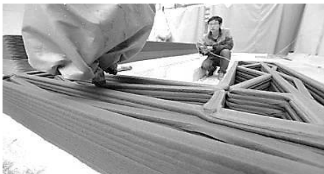
Рис. 15. Установка их из четырех 3D-принтеров
