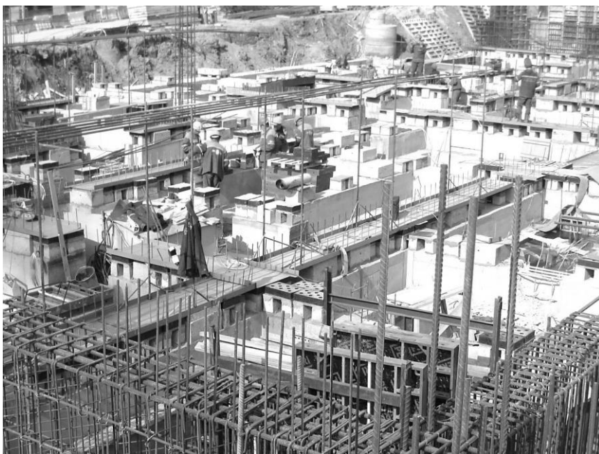
Рис. 1. Монтаж виброизоляторов при строительстве лечебно-диагностического корпуса в технической зоне Минского метрополитена
