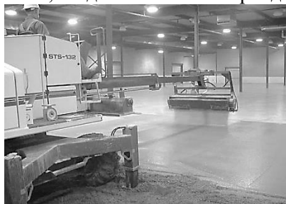
Рис. 2. Высокоэффективное распределение материала по поверхности (Topping spreader)
