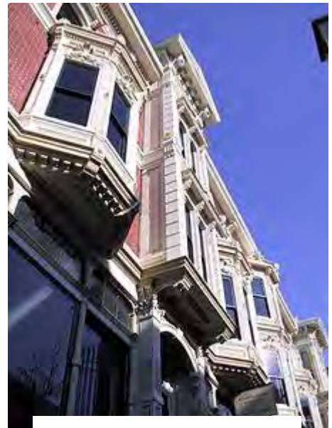
Façade de type victorien
