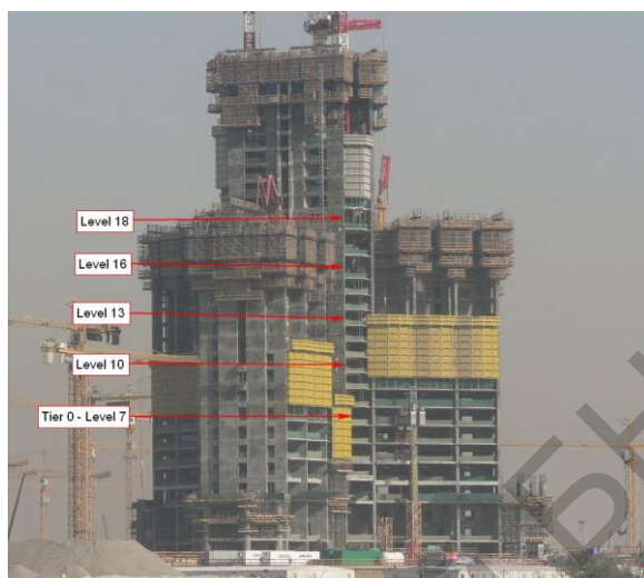
Рисунок 3 – Конструкция железобетонного каркаса
