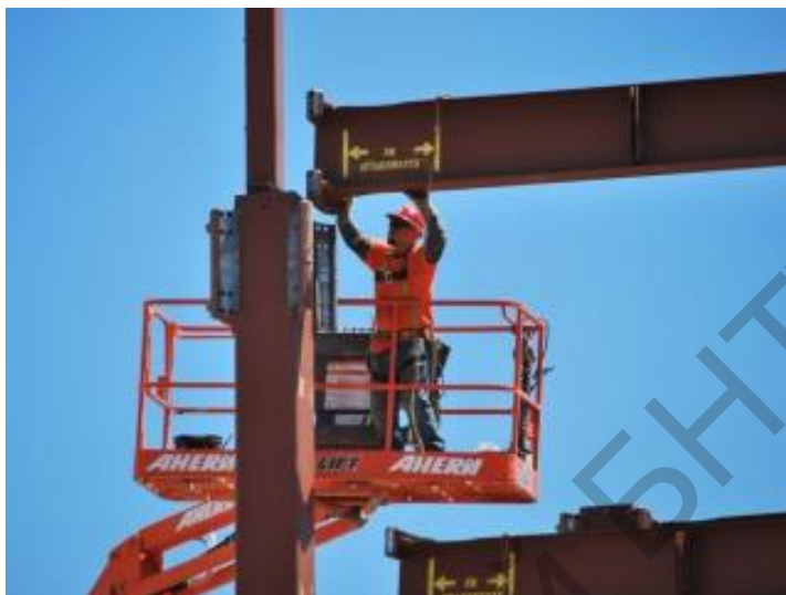
Рисунок 5 – Монтаж балки по системе ConXL
