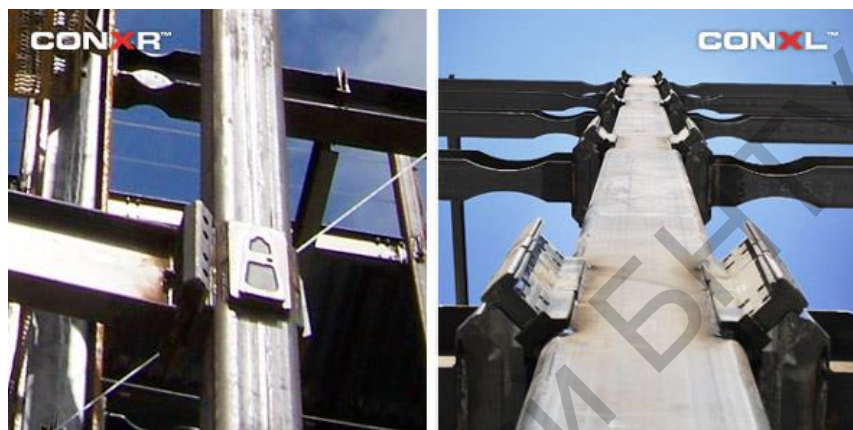
Рисунок 2 – Колонны по системе ConXL и ConXR
