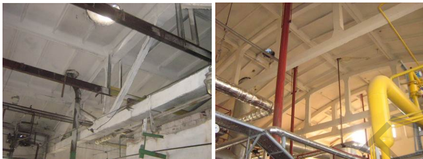
Рисунок 1. Система стропильных конструкций покрытия
