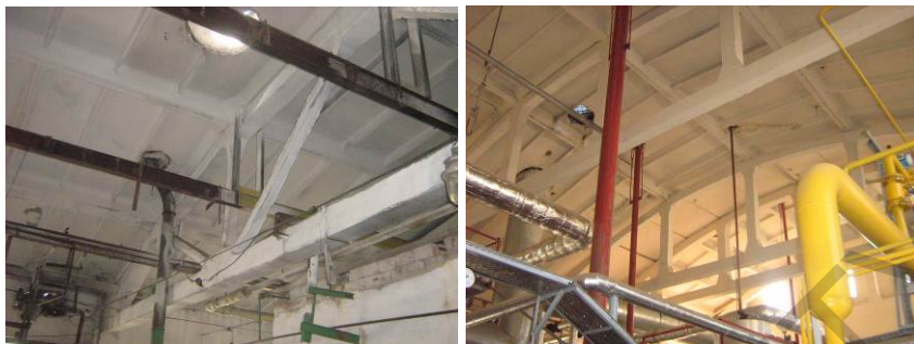
Рисунок 1. Система стропильных конструкций покрытия
