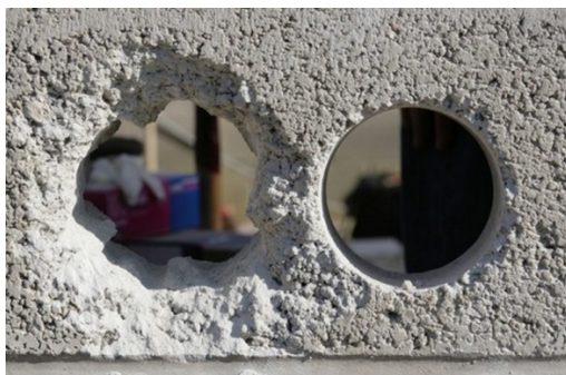
Рис..5 Пример использования алмазов в строительстве при устройстве проемов
