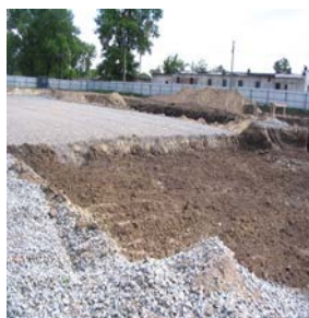
Рис. 4. Снятие слоев основания из-за невозможности в уплотнения
