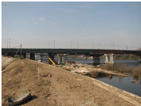
Рис. 3. Второй этап передвижки. Стык БК27-аванбек у опоры № 4
