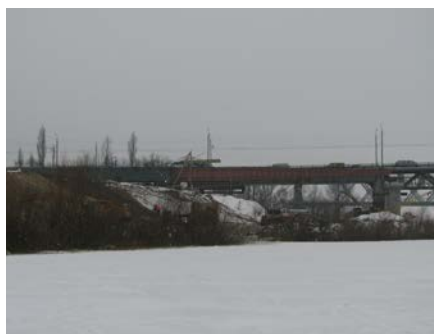
Рис. 2. Первый этап надвигки. Стык БК27-аванбек на опоре № 6
