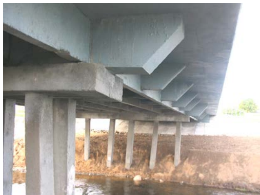
Рис. 6. Вид снизу на фасад моста
