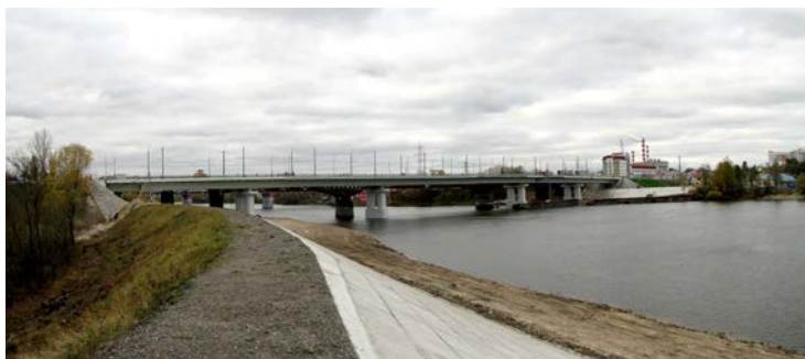
Рис. 1. Общий вид моста через р. Сож в г. Гомель
