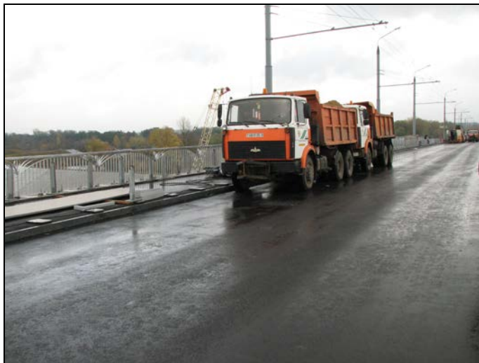
Рис. 7. Установка испытательной нагрузки для линий влияния
