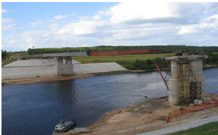
Рис. 2. Надвижка пролетного строения: а) вид ППУ у опоры № 3; б) общий вид надвижки
