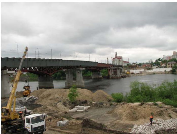
Рис. 4. Третий этап передвижки. Стык БК27-аванбек в пролете № 3
