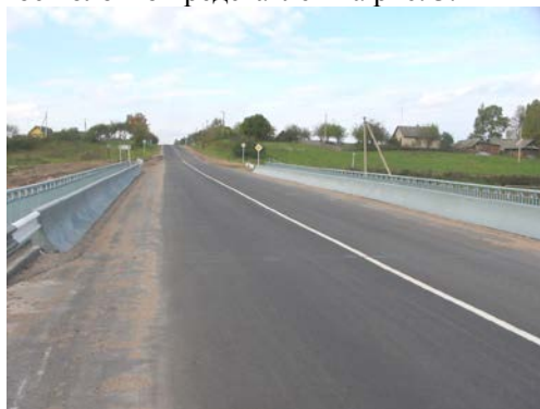
Рис. 3. Мостовое полотно после капитального ремонта
