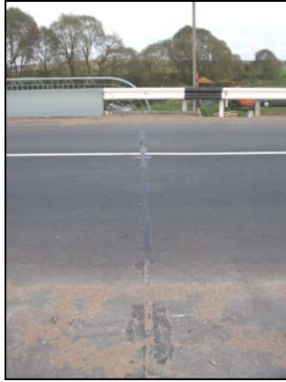
Рис. 4. Температурный шов на сопряжении моста с подходом
