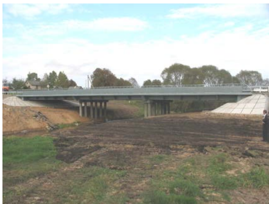
Рис. 1. Общий вид моста после капитального ремонта
