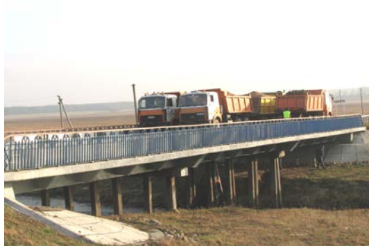
Рис. 7. Установка испытательной нагрузки
