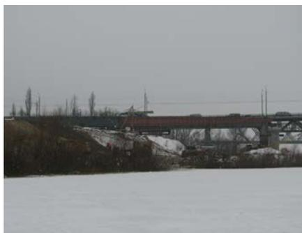
Рис. 2. Первый этап надвигки. Стык БК27-аванбек на опоре № 6
