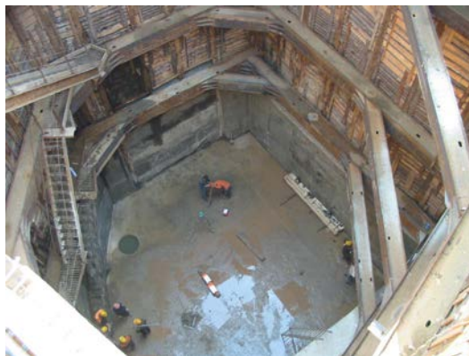
Рис. 1. Разработка грунта котлована
