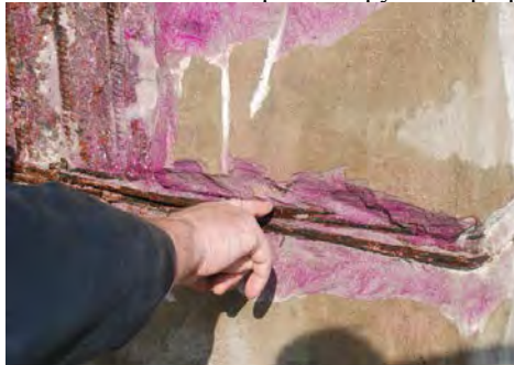
Рисунок 1. - Общий вид железобетонной конструкции с нанесенным раствором
