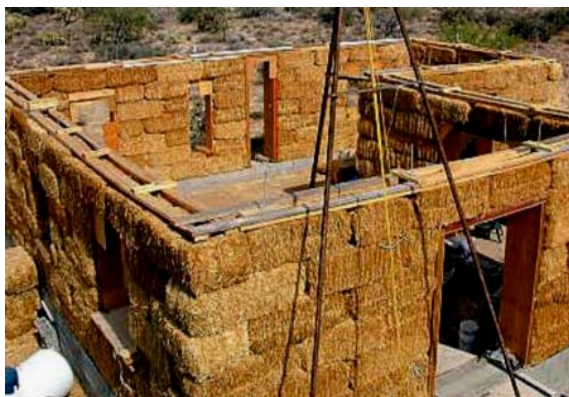
Рисунок 3 – процесс возведения дома из соломенных блоков
