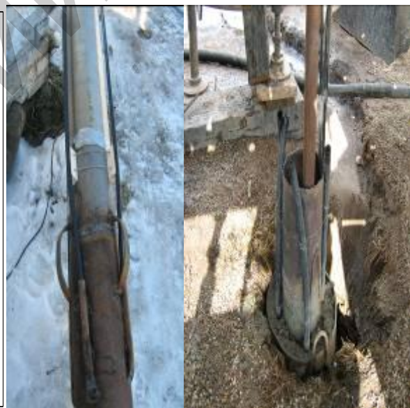
Рисунок 4 – Фильтр ( D=219 мм) с затрубной системой регенерации ( d=20 мм) и устье скважины
