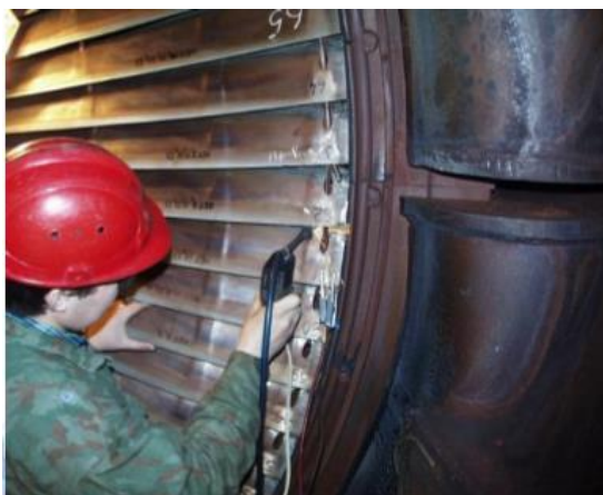
Рисунок 3 – Нанесение металлатором защитных покрытий на лопатки 29-й ступени через конденсатор при ремонте турбины К-300-240 ЛМЗ ОАО «Рязанская ГРЭС» (ст. №3)
