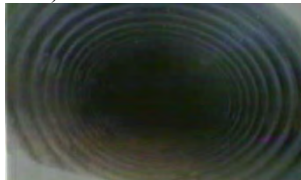
Рис. 3. Состояние коллектора 26-2-1 после промывки
