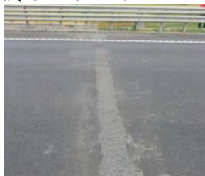
Рис.2 Щебеночно-мастичный деформационный шов
