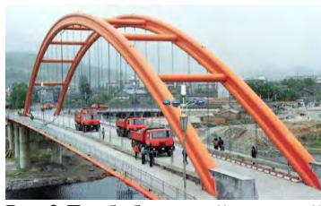
Рис.2 Трубобетонный арочный мост Wangchang East River Bridge.
