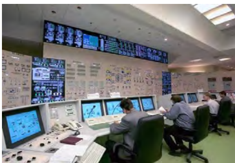
Общий вид системы управления метрополитеном
