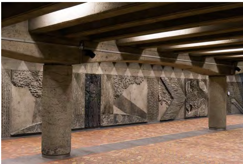
Общий вид колон, выполненных из трубобетона
