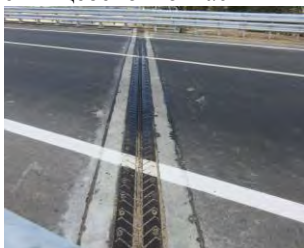
Рис.1 Деформационный шов КРМ.
