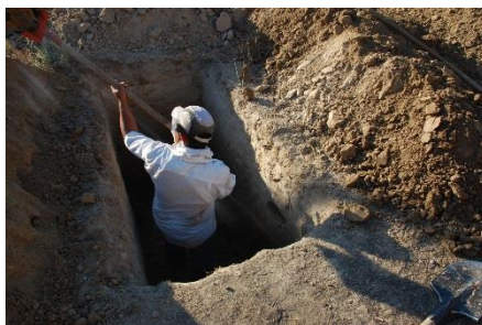
Рисунок 3. – Выкапывание шурфа
