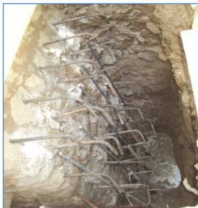
Рисунок 3. – Восстановление фундамента с помощью извести в Аль-Аземском дворце
