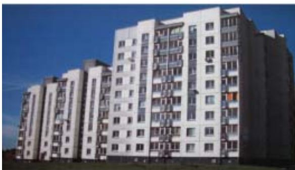
Рисунок 1 – Серия жилых домов, построенных из объемных блоков 3А-ОПБ
