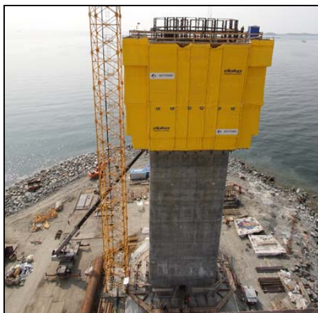
Рисунок 2 – Самоподъемная опалубка
