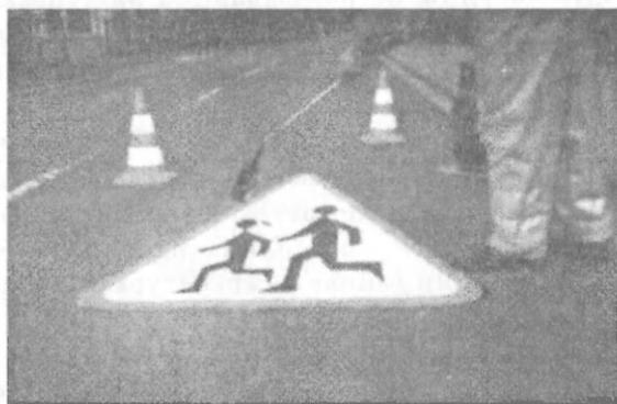
Рис. 5.13. Полимерное покрытие, нанесенное методом наклеивания
