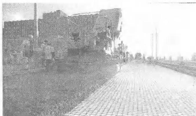
Рис. 6.8. Укладка слоя асфальтобетона поверх слоя из синтетического материала
