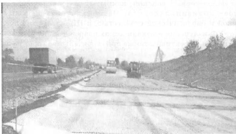
Рис. 6.6. Применение синтетических материалов для упрочнения земляного полотна
