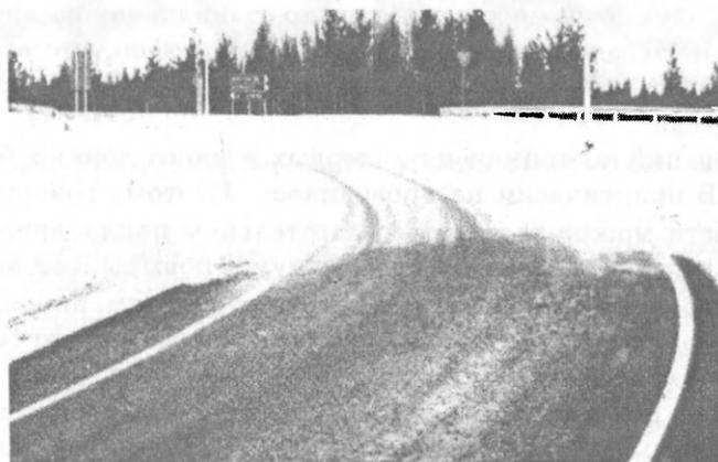
Рис. 5.4. Вид покрытия с противогололедным эффектом
