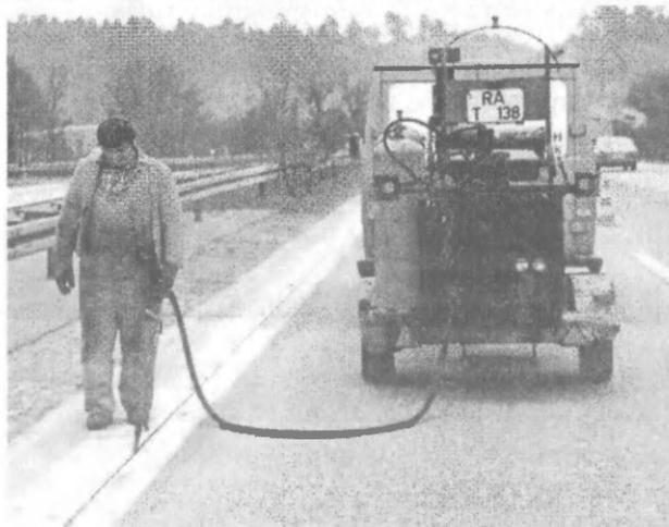
Рис. 6.1. Заполнение шва герметиком
