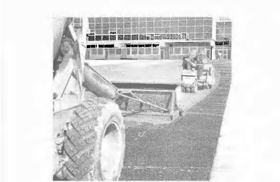
Рис. 3.8. Виброраспределитель для устройства покрытия по способу раздельного бетонирования
