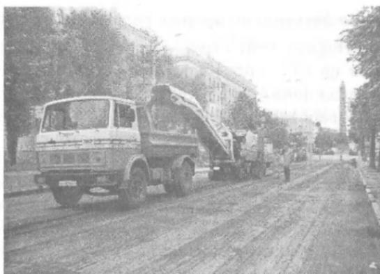
Рис.4. 5. Общий вид фрезы фирмы “Wirtgen”
