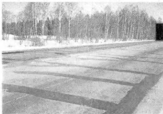
Рис. 6.10. Вид покрытия с заделанными отраженными трещинами после 2-х лет эксплуатации
