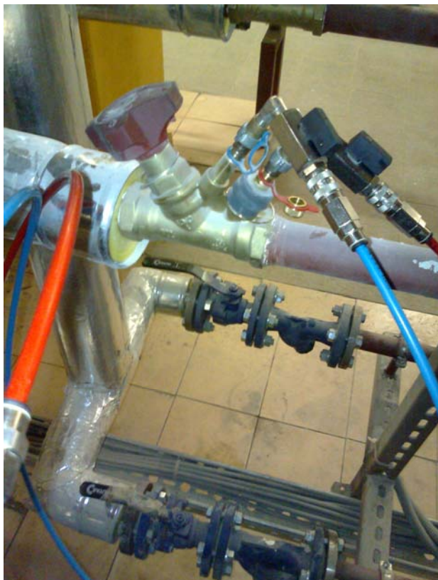
Рис. 7.2. Подключение шлангов и измерительных игл к штуцерам балансового клапана фирмы Heimeier (TA)
