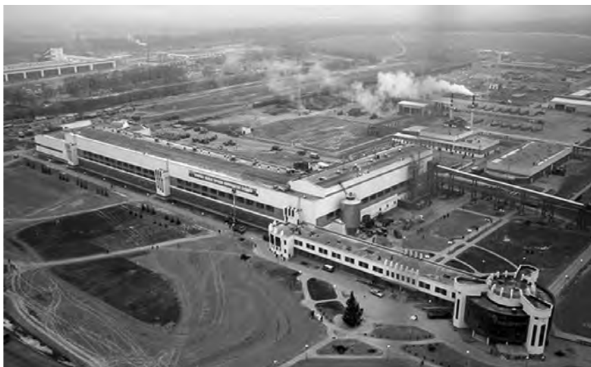
Рис. 4.3.36. Завод по производству газетной бумаги с лесопильным производством в Шклове
