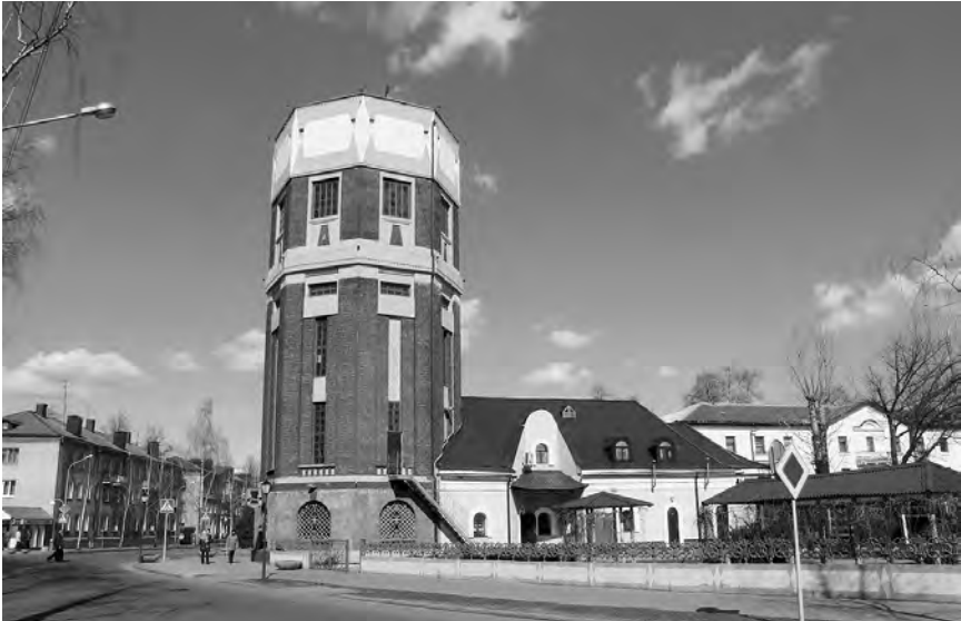
Рис. 4.3.14. Водонапорная башня в Бобруйске
