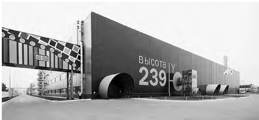
Рис. 3.1.7. Цех «Высота 239» трубопрокатного завода в Челябинске, Россия
