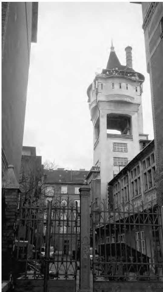
Рис. 2.3.23. Водонапорная башня в Милане, Италия
