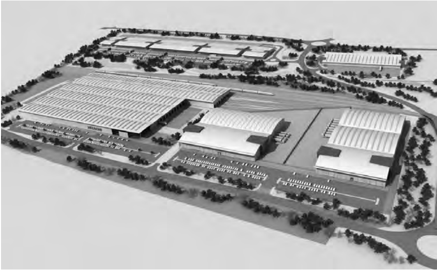
Рис. 3.1.5. Завод по производству скоростных поездов в Ньютоне, Великобритания
