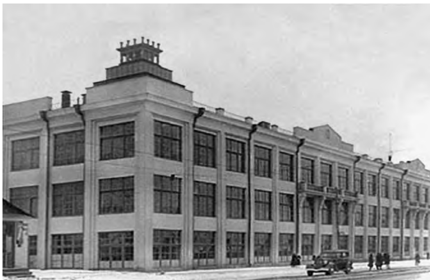
Рис. 4.3.19. Сборочный корпус радиозавода в Минске, первоначальный вид
