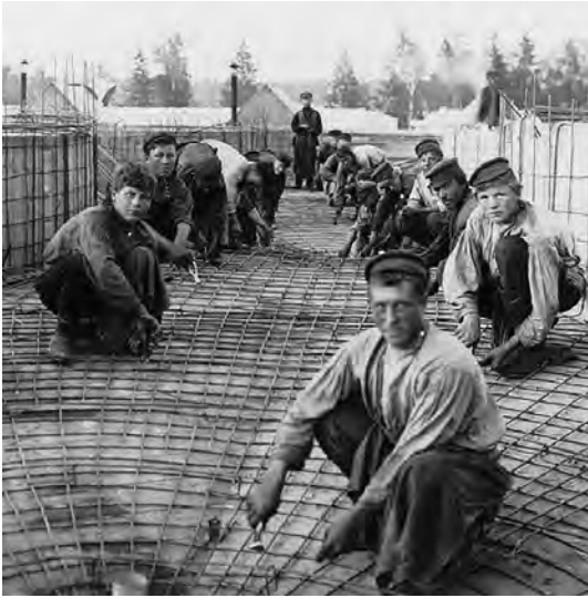
Рис. 4.1.3. Строительство покрытия Богородско-Глуховской мануфактуры, Россия
