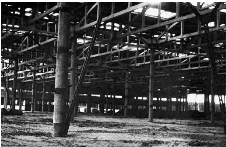
Рис. 3.1.14. Корпус машиностроительного предприятия промышленного узла в Сморгони, Беларусь
