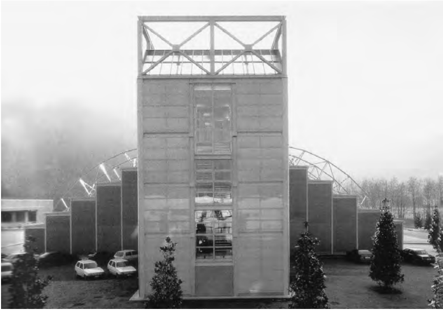
Рис. 4.2.17. Мусороперерабатывающий завод в Вербании, Италия
