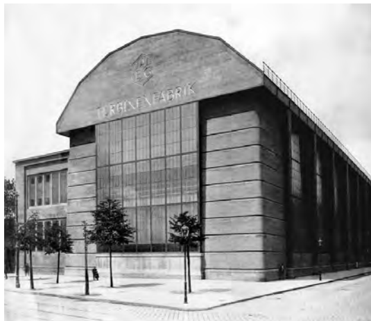
Рис. 2.4.20. Фабрика турбин в Берлине, Германия
