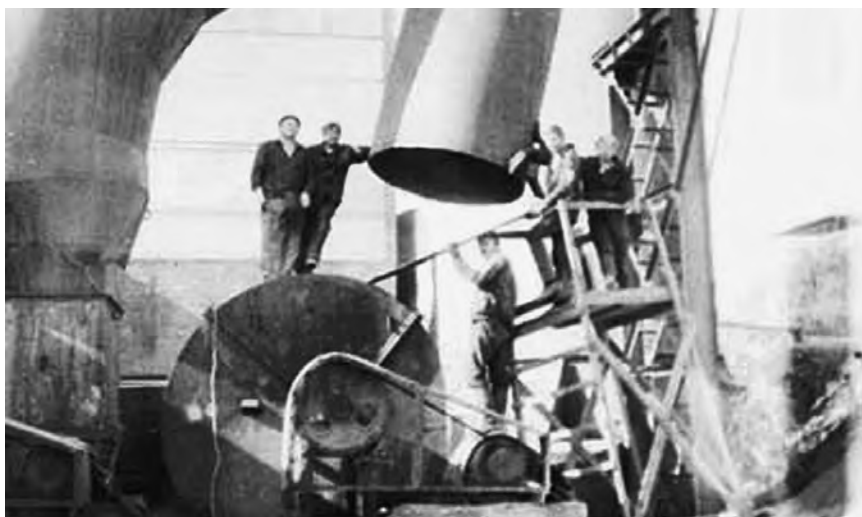
Рис. 4.3.29. Монтаж оборудования на заводе Ударник в Минске
