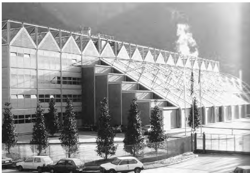
Рис. 4.2.16. Мусороперерабатывающий завод в Вербании, Италия
