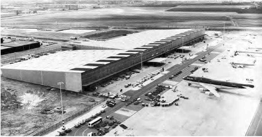
Рис. 3.1.16. Логистический склад аэропорта в Шипхолье, Нидерланды
