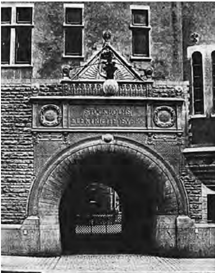
Рис. 2.4.6. Завод по производству электрических изделий Фердинанда Боберга в Стокгольме, Швеция
