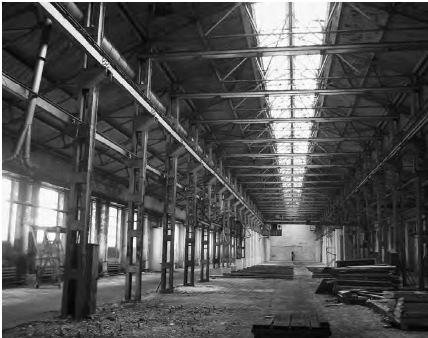
Рис. 4.3.4. Фонарь верхнего света производственного корпуса завода Гигант (Энергия, МЗОР) в Минске
