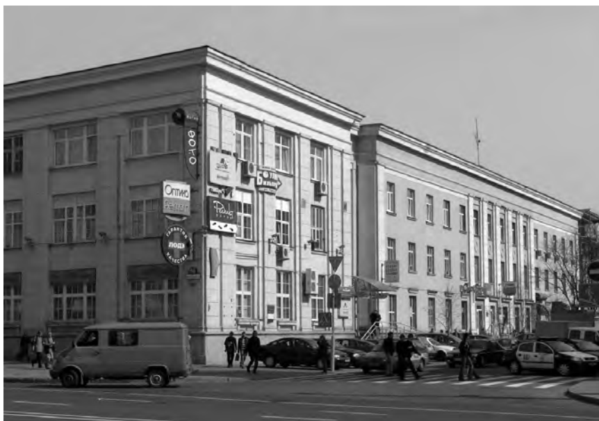
Рис. 4.3.20. Сборочный корпус радиозавода в Минске, современное состояние
