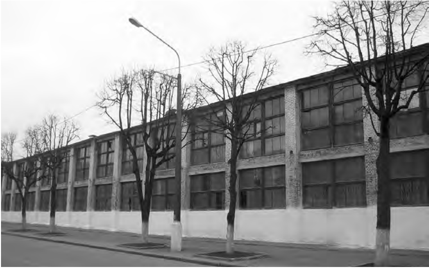
Рис. 4.3.21. Станкостроительный завод им. Кирова в Минске
