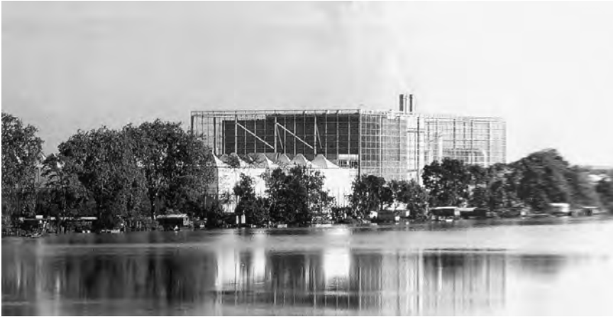
Рис. 4.2.25. Мусоросжигательный завод в Беглесе, Франция
