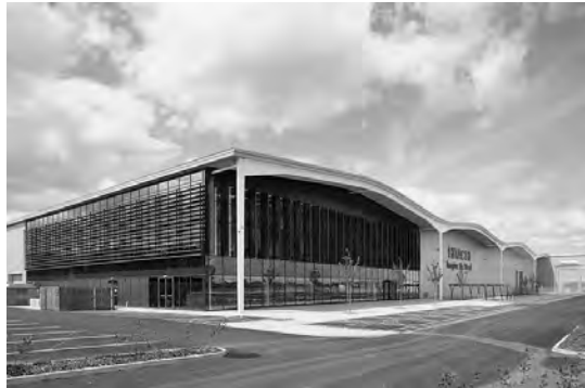
Рис. 3.1.6. Сборочный корпус завода по производству скоростных поездов в Ньютоне, Великобритания
