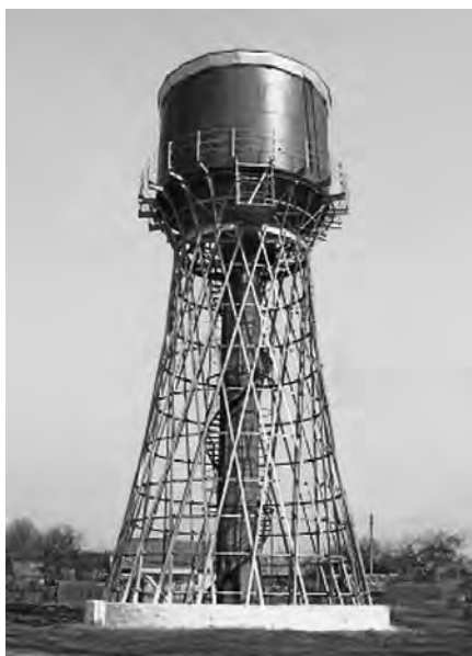
Рис. 4.3.27. Водонапорная башня в деревне Звенячи (железнодорожная станция Коханово)
