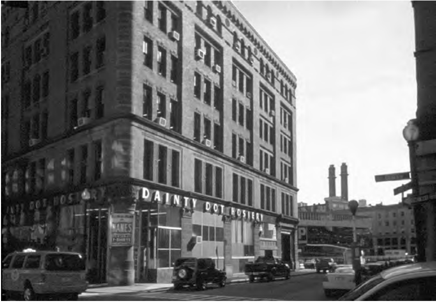
Рис. 2.3.3. Промышленное здание в Бостоне, США
