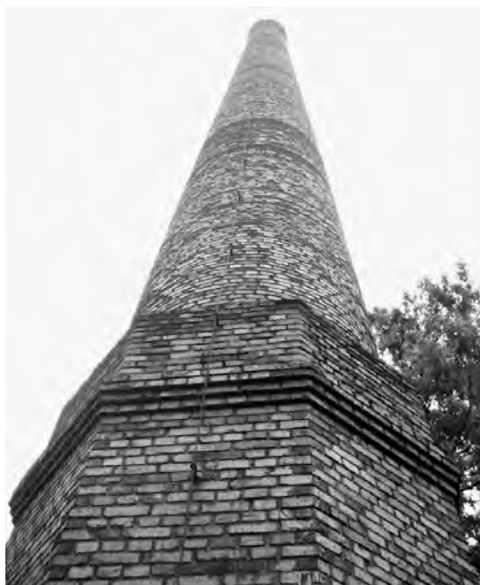
Рис. 2.3.26. Труба машиностроительного предприятия в Минске, Беларусь
