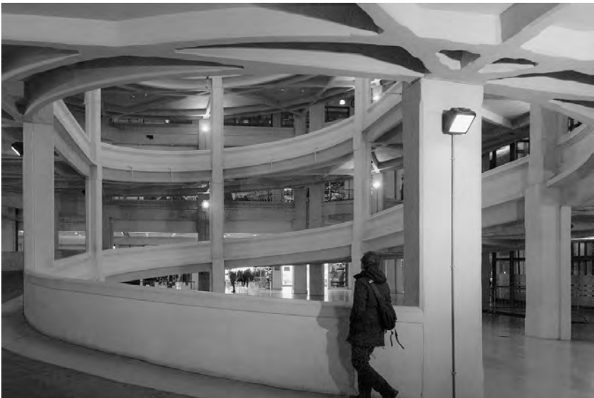
Рис. 2.3.7. Внутренняя рампа сборочного корпуса предприятия Фиат в Турине, Италия
