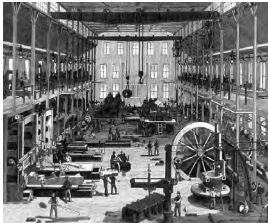
Рис. 2.1.4. Мостовой кран в пролетном здании, США
