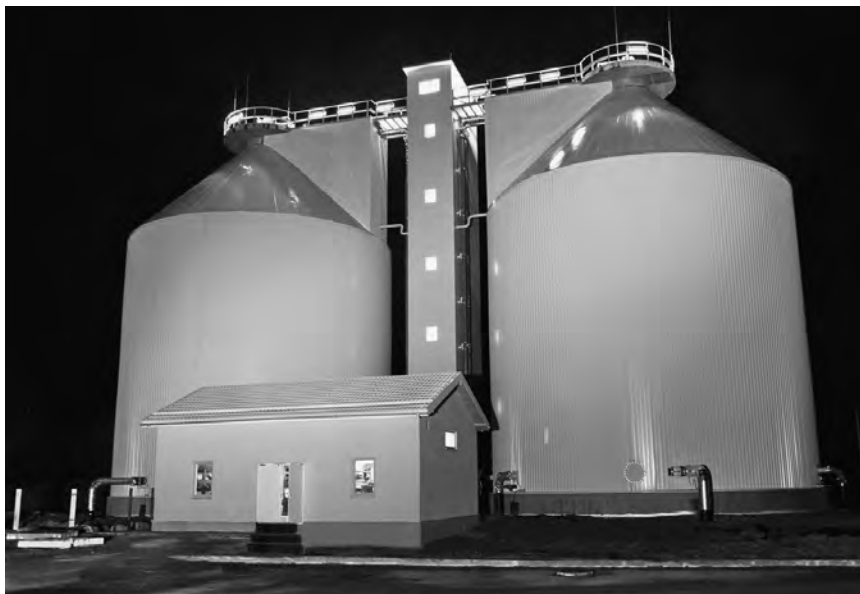
Рис. 4.2.3. Завод по переработке отходов в Бресте, Беларусь
