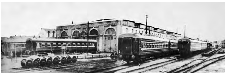
Рис. 4.3.8. Вокзальный (вагоноремонтный) завод в Минске, основной корпус
