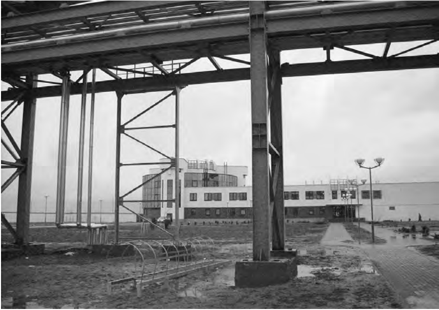
Рис. 4.3.37. Завод по производству газетной бумаги с лесопильным производством в Шклове
