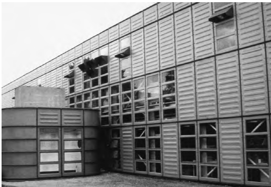
Рис. 3.1.24. Распределительный центр, архитектор Н. Гримшоу, Великобритания
