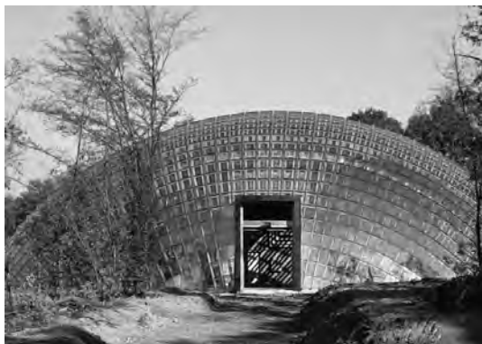
Рис. 3.1.19. Производственный корпус института лесоводства в Марш-эн-Фаменн, Бельгия
