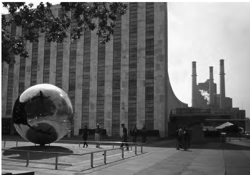
Рис. 3.2.4. Теплоэлектростанция в центре Нью-Йорка, рядом со зданием секретариата ООН, США
