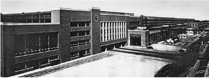
Рис. 2.3.19. Кузнечный цех завода Райдж в Дيابорне, США
