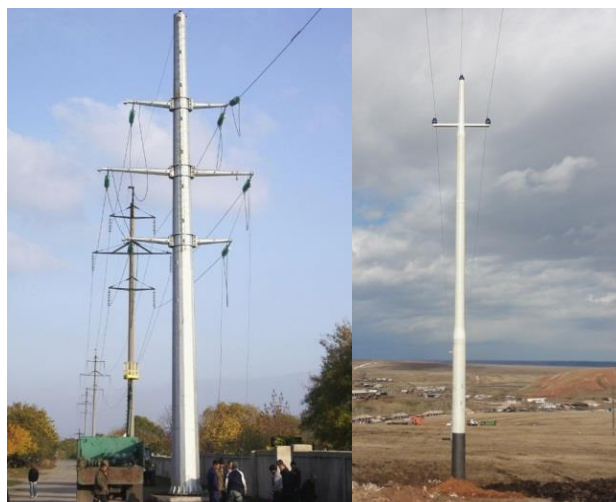
Рисунок 6. - Опоры из стальных труб
