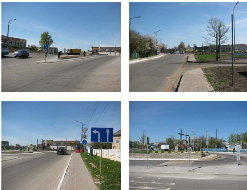
Рисунок 5 – Вид перекрестка после реконструкции в кольцевой (виды с различных входов)
