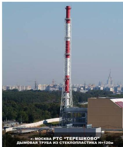
Рис. 3. Стеклопластиковые дымовые трубы
