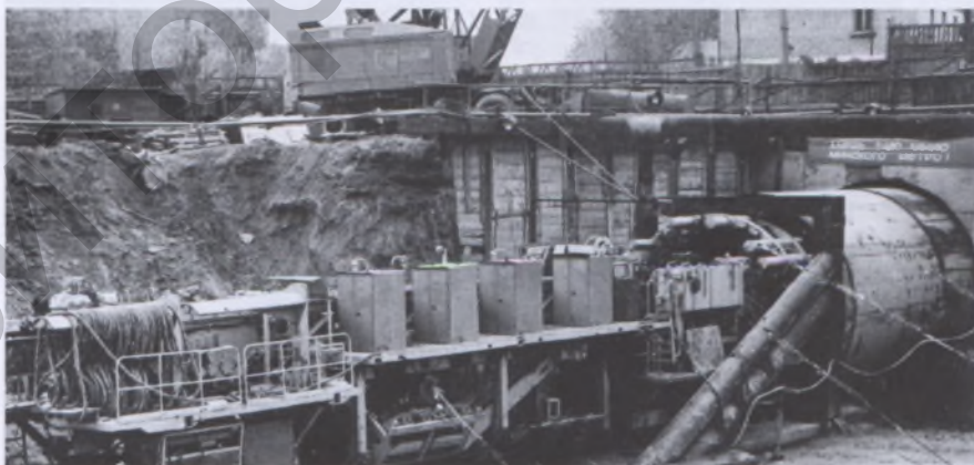
Фото 3 — Механизированный щитовой комплекс КТ – 5.6-Д 2
