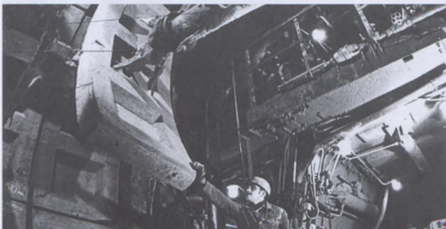
Фото 4 — Монтаж тоннельной обделки из железобетонных блоков тоннельным укладчиком ТУ – 3гп
