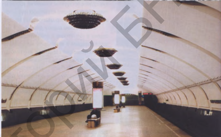
Фото 8 — Станция «Парк Челюскинцев», выполненная из монолитного железобетона. Монтаж арматуры сводной части обделки
