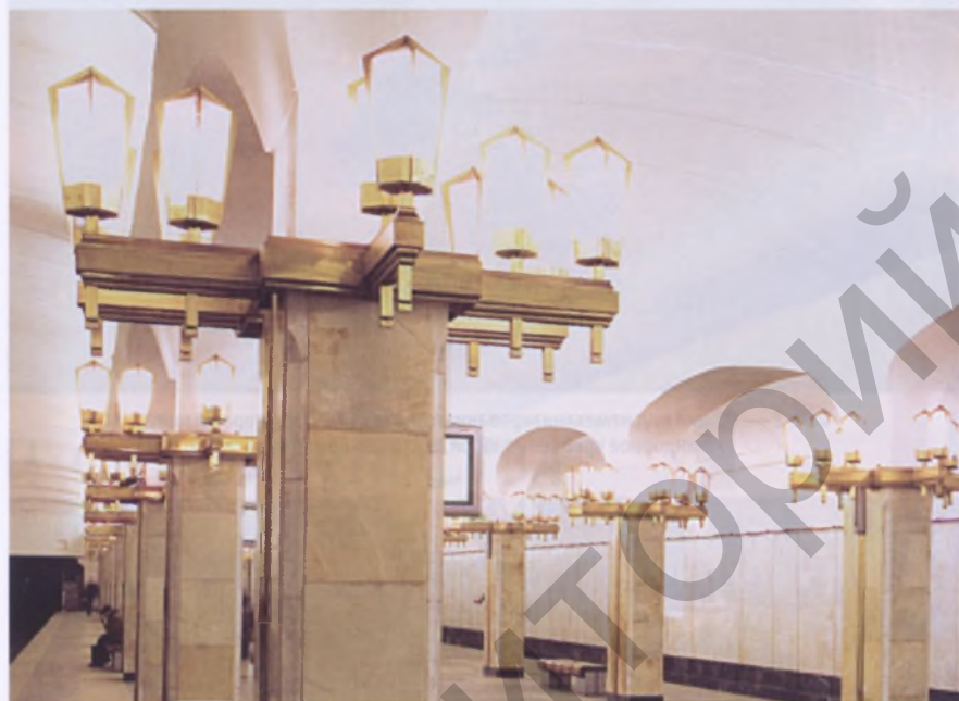
Фото 6 — Станция «Пушкинская». Конструкция станции представляет собой трехпролетное подземное сооружение со сводчатыми перекрытием, выполненным в сборно-монолитном варианте
