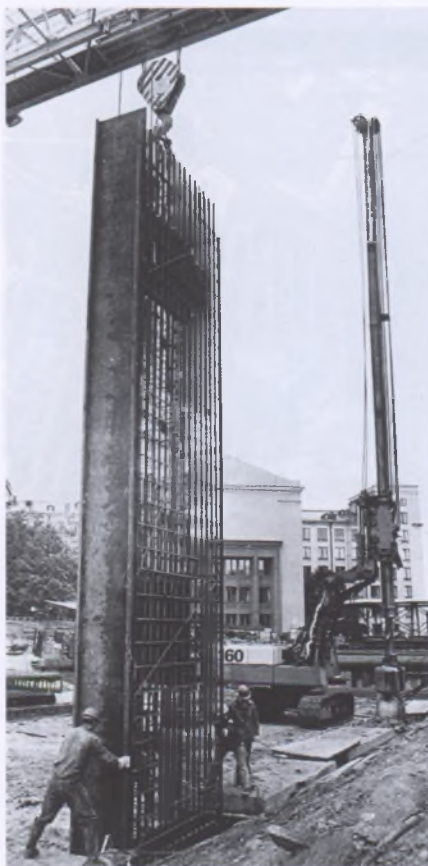
Фото 10 — Опускание на очередной захватке арматурного каркаса в глубокую траншею, разрабатываемую штанговым грейфером при сооружении монолитной траншейной стены по технологии «стена в грунте»
