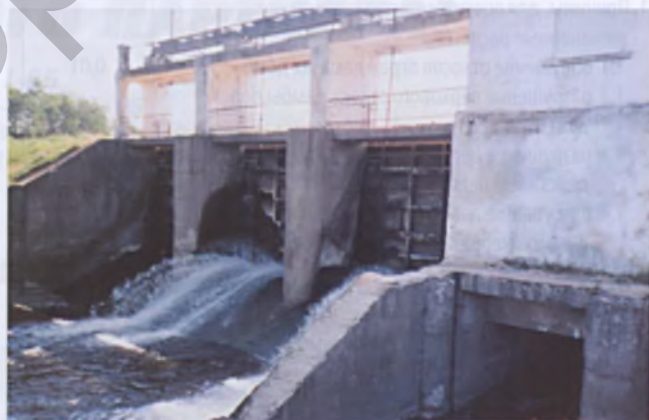
Рисунок 2 — Бетонная водосливная плотина
