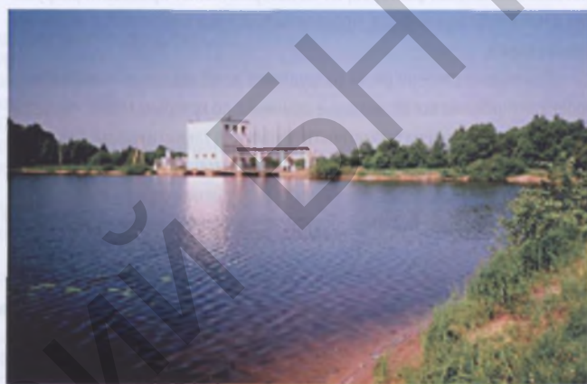
Рисунок 1 — Общий вид со стороны водохранилища на здание ГЭС, водосливную плотину и левобережную земляную плотину
