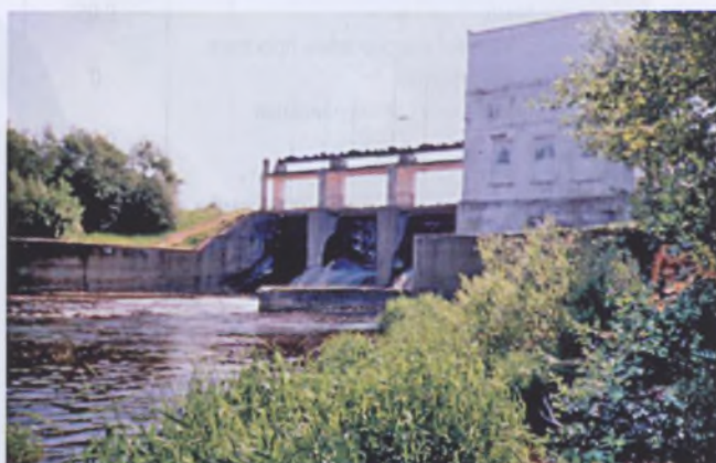
Рисунок 3 — Здание ГЭС, водосливная плотина и правобережная земляная плотина
