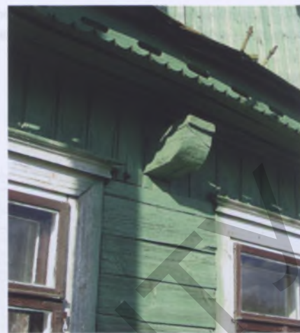
Рисунок 6 — Торец «трама» на главном фасаде жилого дома в Ракове Воложинского района
