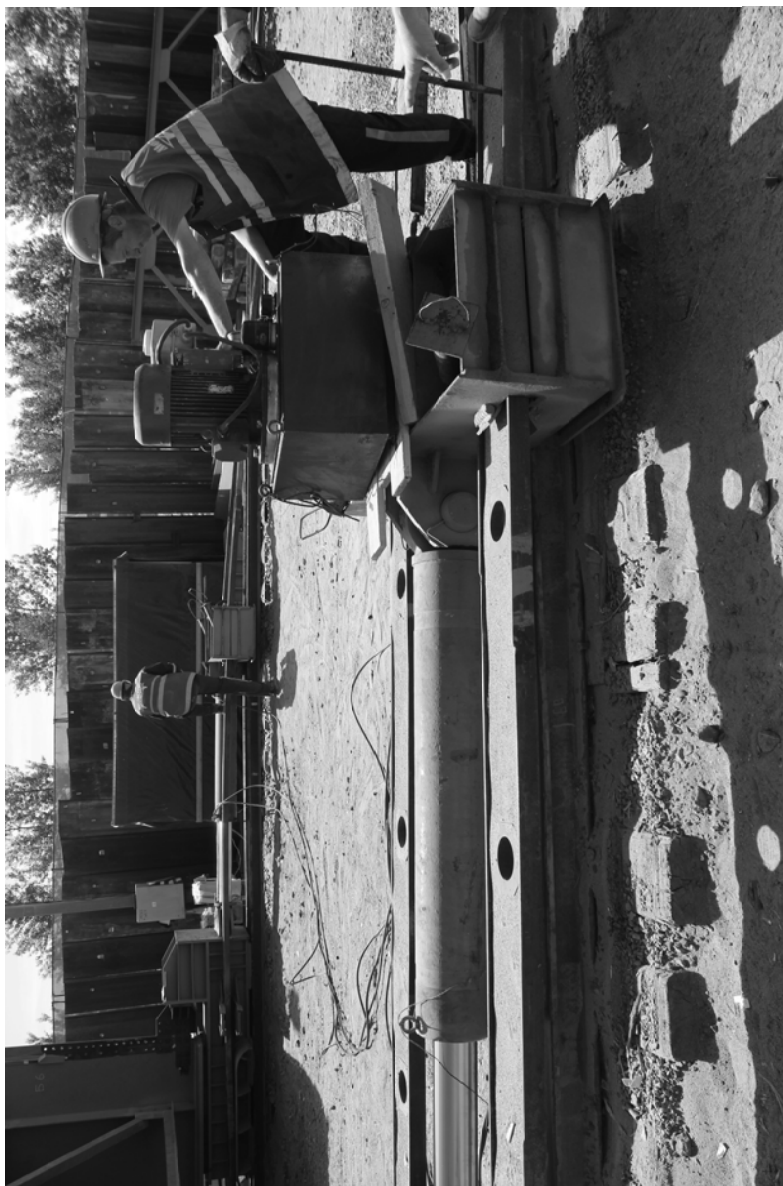
Рисунок 6.7. – Толкающие домкраты для навивки пролетного строения
