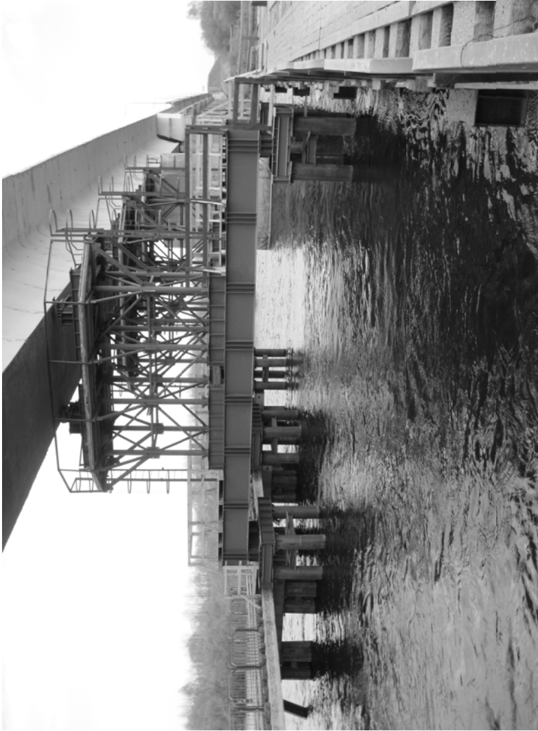
Рисунок 3.1с. – Временная опора
