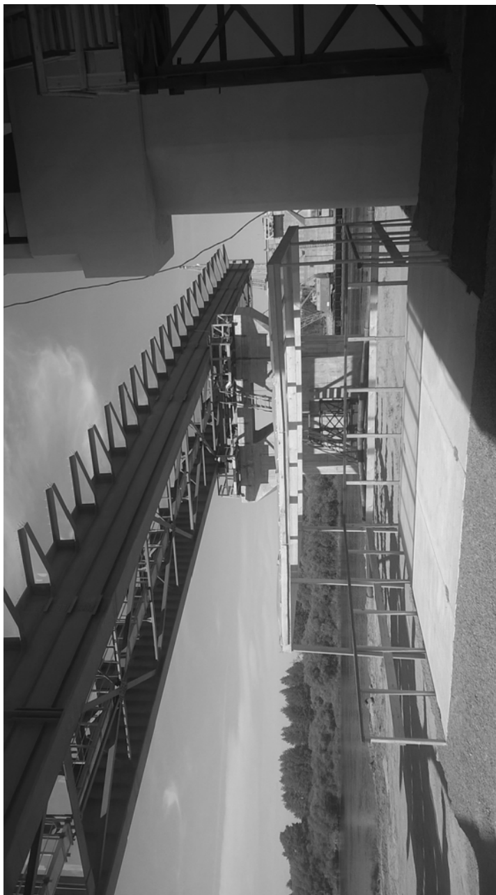
Рисунок 6.3в. – Надвижка пролетного строения
