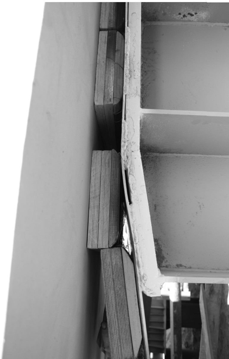
Рисунок 6.8. – Надвижка пролетного строения (узел скольжения)
