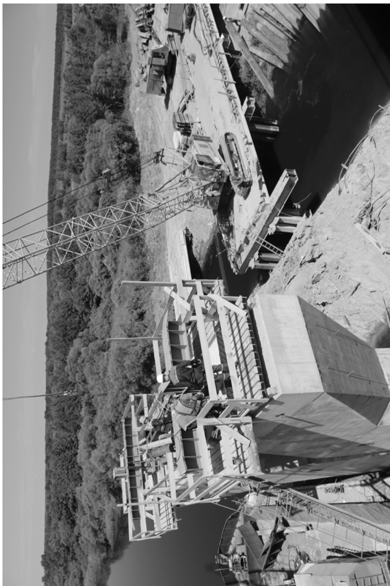
Рисунок 6.2б. – Обустройство опоры перед навивкой пролетного строения
