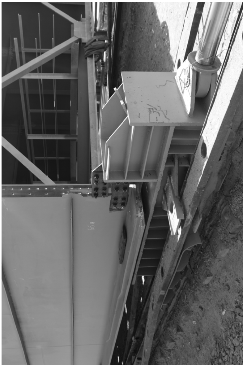
Рисунок 6.6. – Узел сопряжения толкающего домкрата и пролетного стропения
