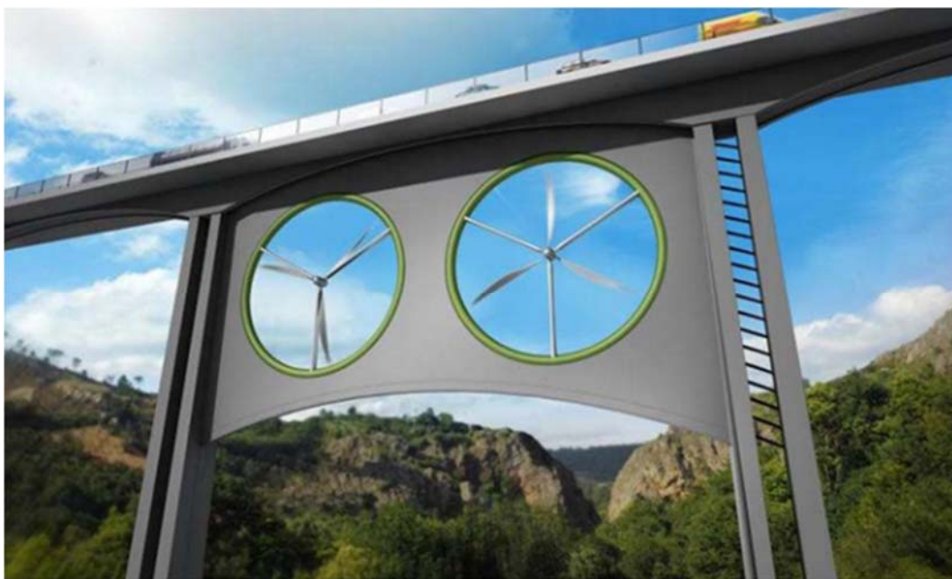
Рисунок 3 – Виадук с ветровыми турбинами между опорами
