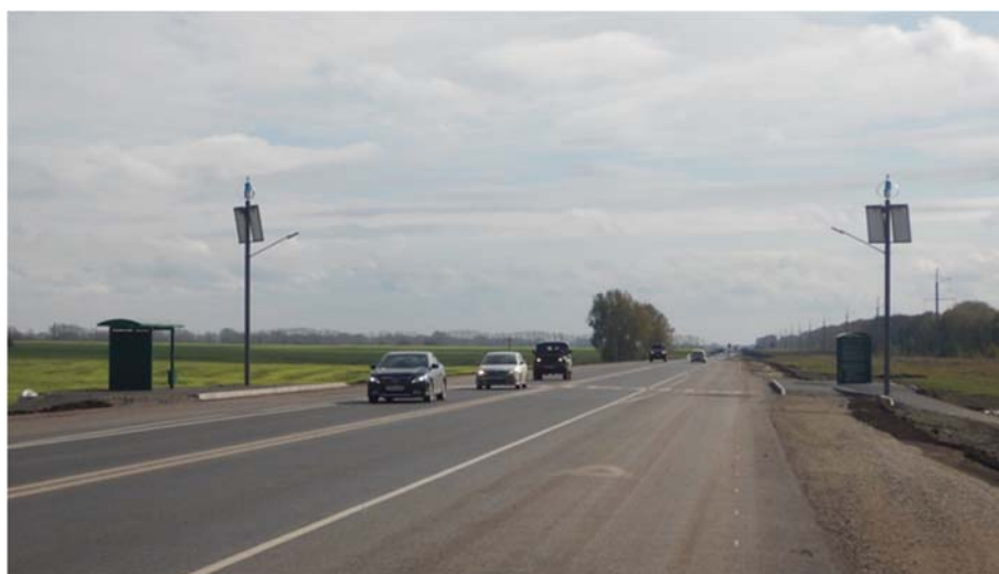
Рисунок 1 – Ветро-солнечные системы для освещения пешеходного перехода
