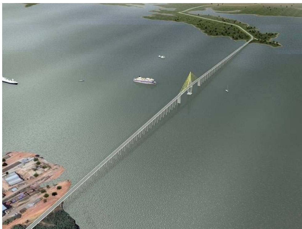
Рисунок 3 – Общий вид моста «Manaus-Iranduba» через реку Амазонка Фото с сайта http://www.top-kirov.ru/unikalnye-proekty-gorodov-budushhego.php , дата обращения 17.06.2017г.)
