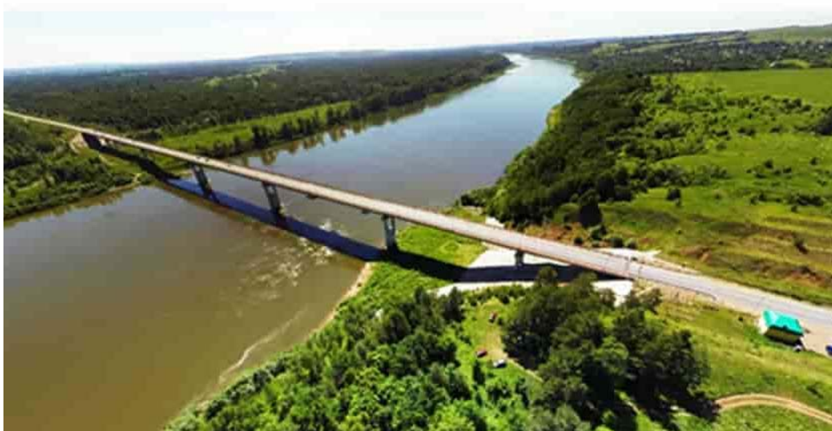
Рисунок 3 – Общий вид моста
