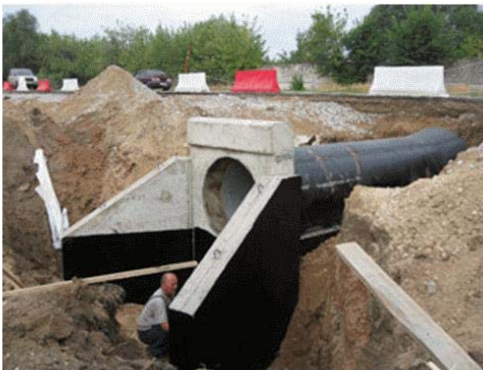
Рисунок 2 – Пример нанесения битумной мастики
