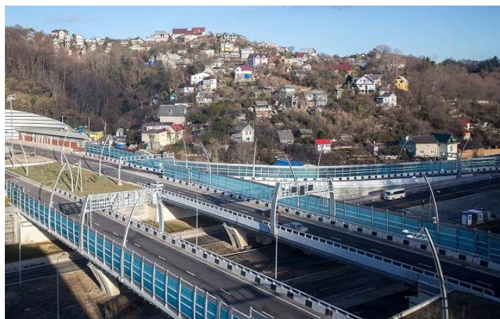
Рисунок 4 – Путепровод с шумозащитным экраном
