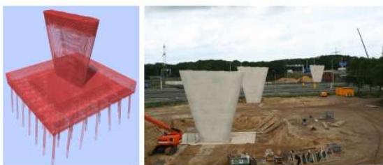
Колонна моста в Kerensheide, Movares, Utrecht, Нидерланды Construction site copyright Heijmans N.V., Rosmalen, The Netherlands
