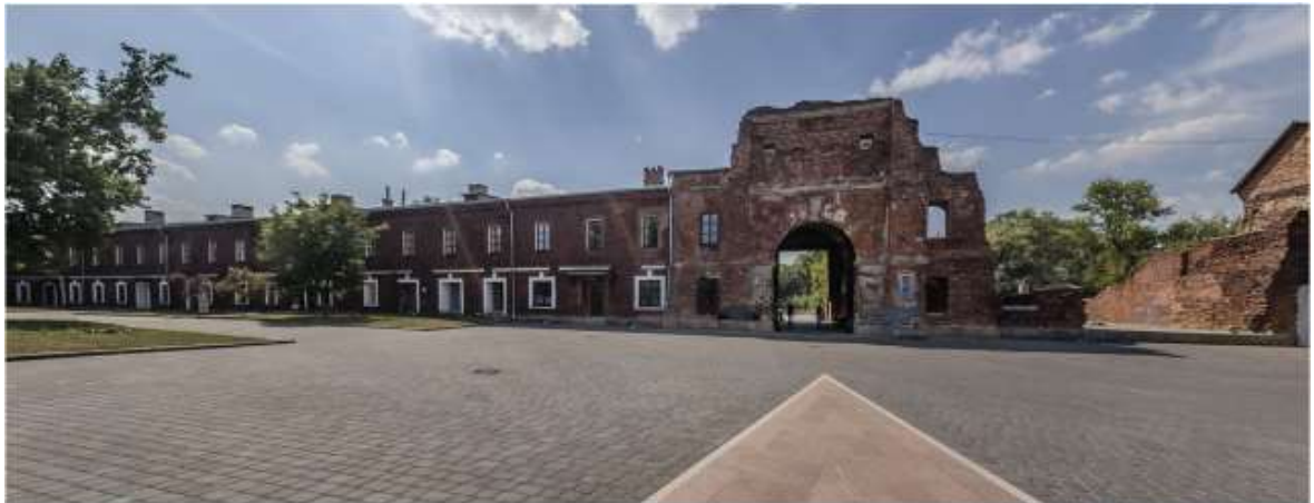
ВНУТРЕННИЙ ФАСАД ТЕРЕСПОЛЬСКИХ ВОРОТ. С НИЗОВОЙ СТОРОНЫ РАСПОЛОЖЕНЫ РАЗРУШЕННЫЕ КАЗАРМЫ
