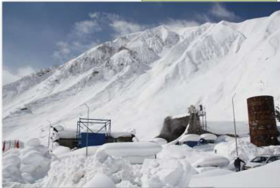
Тоннель располагается в суровых высокогорных погодных условиях с затяжным зимним периодом и объемных атмосферных осадках
